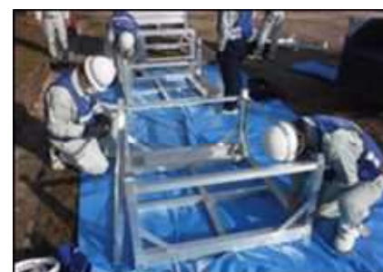
給水タンクの組立訓練
