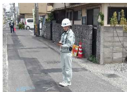
画像共有システムを用いた漏水修繕
