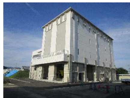
三野浄水場新脱水機棟
