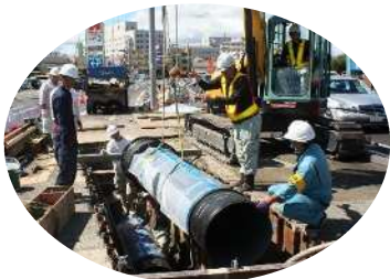
水道管を更新することで、管からの無駄な水漏れを防いでいます
